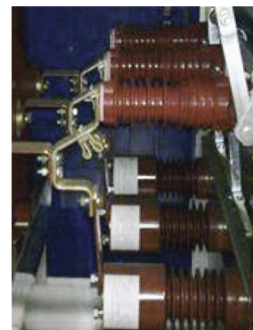
Sensor de tensão (VS-24-I – superior) e sensor de tensão de corrente (CVS-24-I – inferior) instalados em aplicação de switchgear de distribuição
