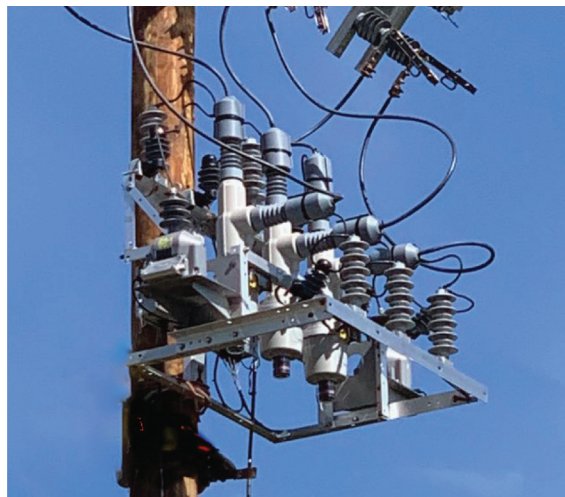
Proteção e medição: Plataformas aéreas instaladas no religador Viper®-ST da G&W Electric (VS-27-0)
