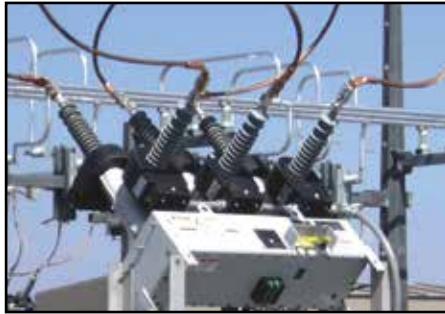
▲ Montagem em ângulo de 45° para aplicações que exigem a mesma carga e altura do conector na lateral da linha.
