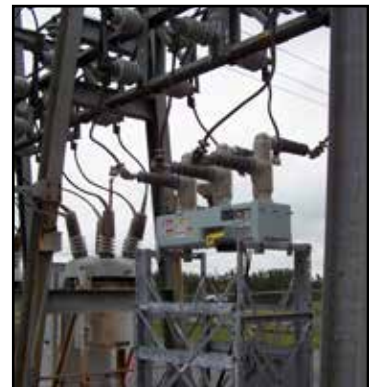
▲ Estrutura montada sob medida necessária para substituição de equipamento de campo petrolífero instalado previamente.
