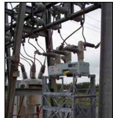
▲ Soporte personalizado, requerido para el reemplazo de equipo de aceite perviamente instalado.
