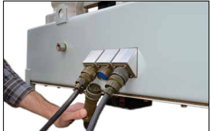
▲ Configuración tradicional: conectores de detección de voltaje de 120VAC de 8 pines, 14 pines para control y CA de 2 pines.
